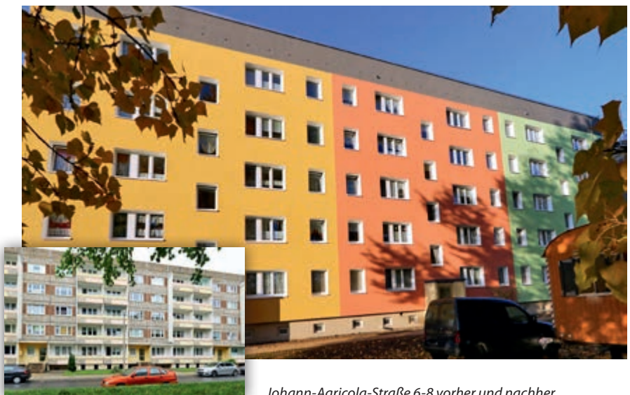
Johann-Agricola-Straße 6-8 vorher und nachher.
